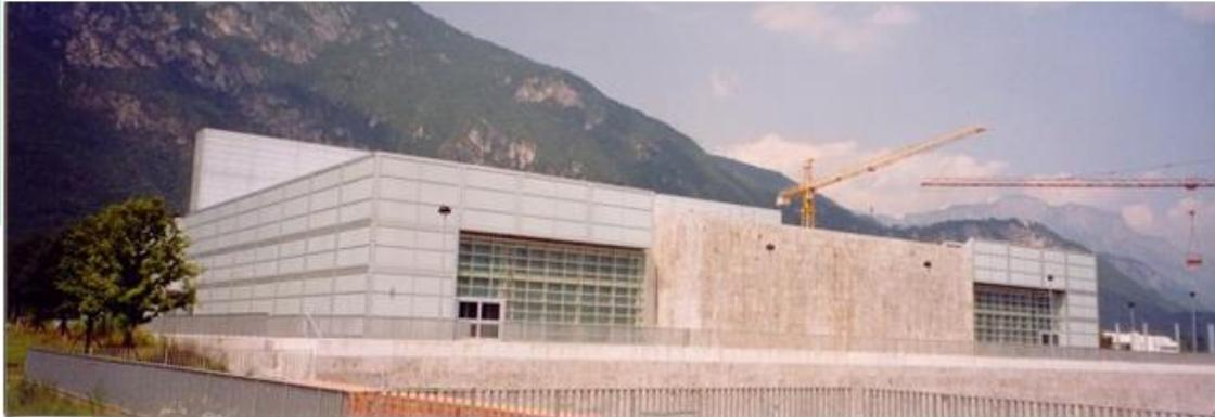
I prospetti sono costituiti da frontiere vetrate doppie e continue che fungono anche da grandi intercapedini d'aerazione in facciata ai fini del confort termico interno. Le coperture sono a sheds nelle zone delle due grandi tribune laterali e cieche sopra il campo centrale. Una serie di percorsi "volanti" a vari livelli consente il collegamento dei flussi pedonali all'intero Centro Sportivo "Ghiaie" ed in particolare alla "piastra del ghiaccio" confinante con il Palazzetto.
