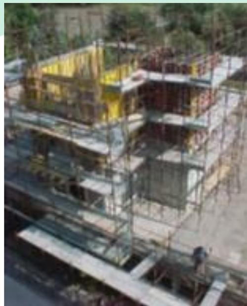
La struttura in sopraelevazione è stata progettata in acciaio per ottenere carichi ridotti sulle fondazioni esistenti, riducendo così le sollecitazioni unitarie sull'imposta ed i parametri di sollecitazione sulle travi rovesce di fondazione esistenti rispetto alla soluzione alternativa, del resto scartata, in c.a., che avrebbe comportato la rinuncia ad un piano di sopraelevazione.
